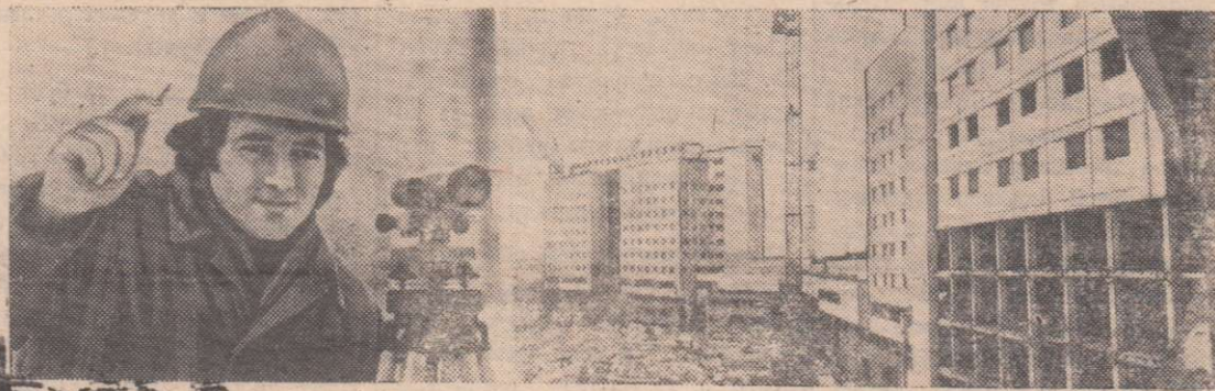
На левом снимке: геодезист СУ № 208 треста Мосстрой-32 Ш. Г. Хабелашвили. На правом снимке: корпуса кардиологического центра.
